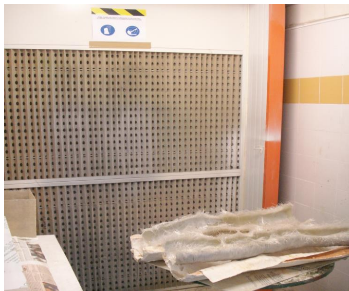
Figura 4. Cabina de ozono y extractor de aire situado en el laboratorio de plásticos de la facultad de Bellas Artes de San Carlos de la UPV .
